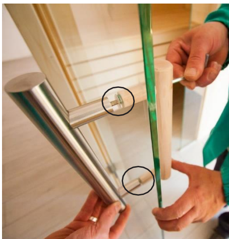
PVC podložku vložte do madla
