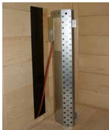
Fig. 2: Posição da caixa de ligação
