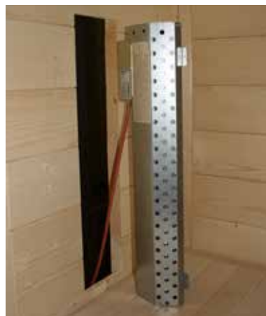
rys. 2: Pozycja skrzynki przyłączowej
