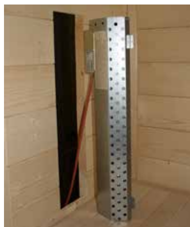
Fig. 2 : Position du boîtier de raccordement
